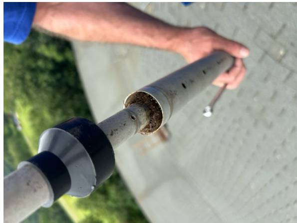
Ausbau der Sicherungsbolzen und Öffnung des ersten Traps. Drainagebohrungen sind frei, ABER woher kommt diese Biomasse hier im Bild rechts? Ähnliches Bild in mehreren der Traps!
