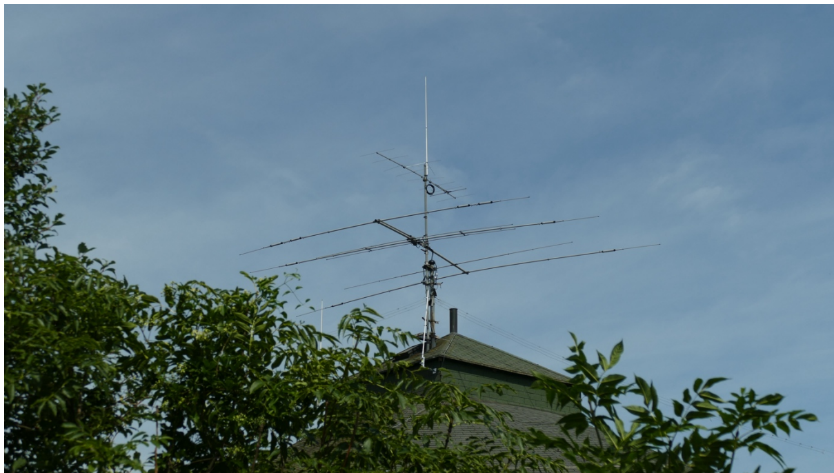
Den schönen historischen Turm 13 „Genoveva“ kennen ja viele bereits. Hier die Antennenanlage.
